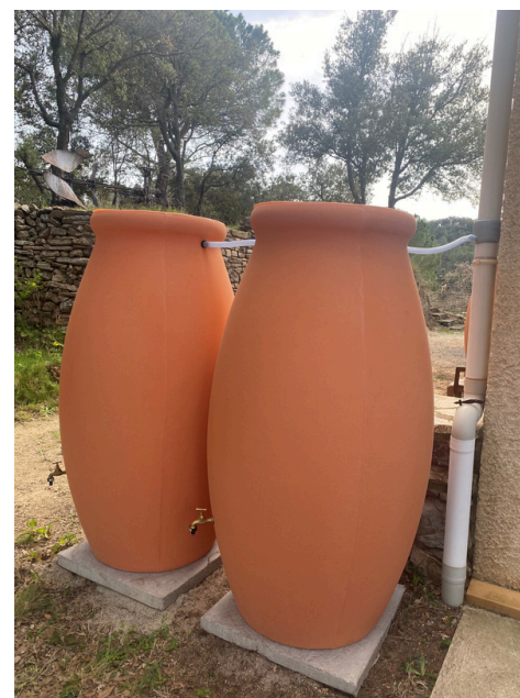
Cuves récupération eau de pluie
