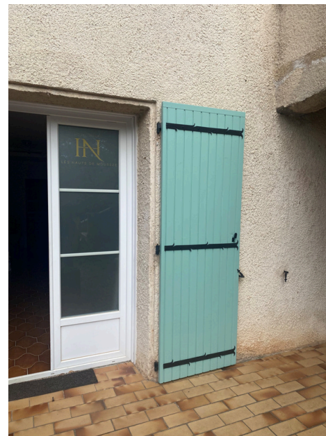
Réfection des volets en bois
