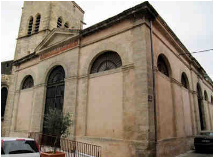
Figure 12 vue sur la Chapelle des Pénitents et les Halles. Source : mairie d'Aniane
