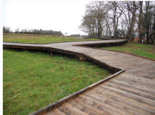
Cheminement piéton en platelages : Bois-loisirs-créations
