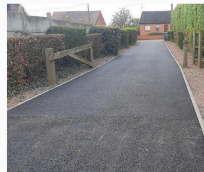
Route en enrobé poreux : La voix du Nord
