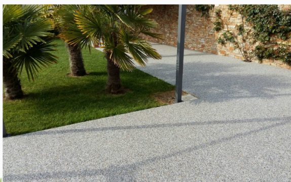
Allée piétonne en résine drainante : Revasol
