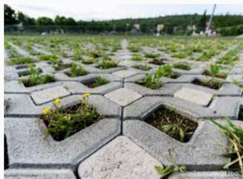
Revêtement en dalles alvéolées : Ecovegetal
